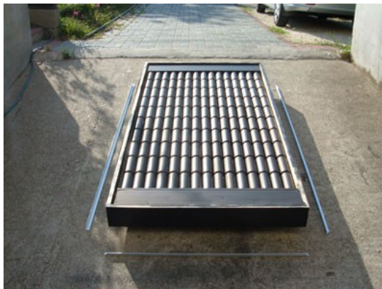
György Károly és Horváth Zoltán napkollektora építése közben
